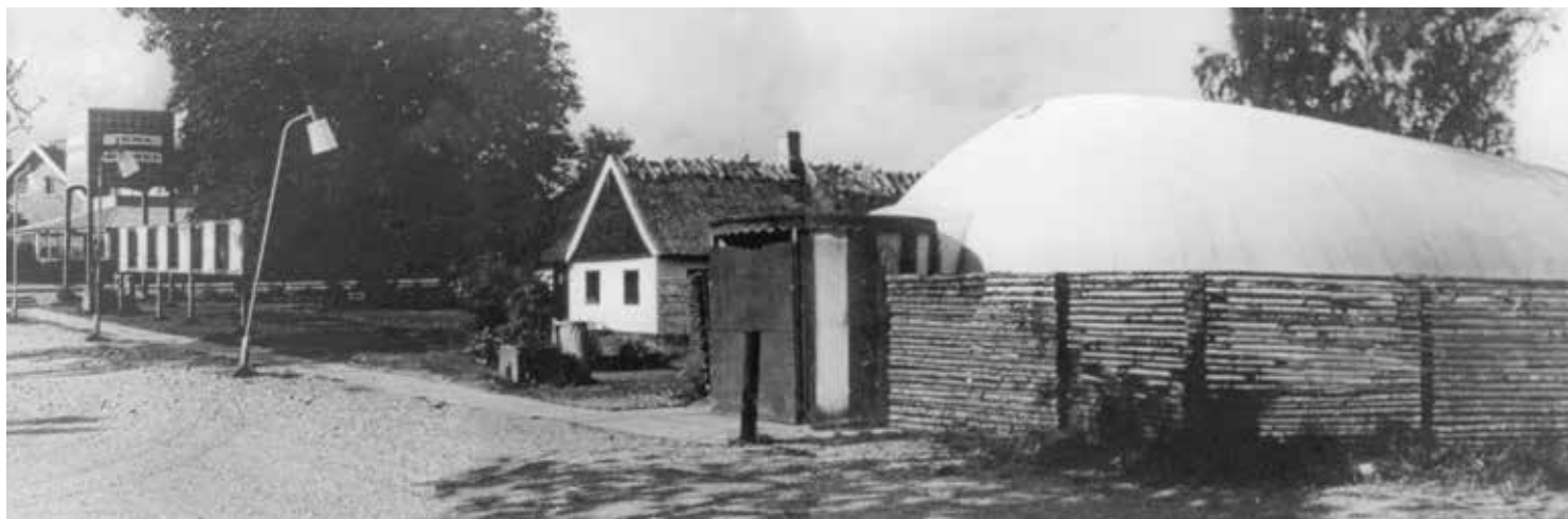
Et sammenklippet billede fra 1960'erne, der viser Irmas oppustede butik og reklameskilt set fra Pilevej.
