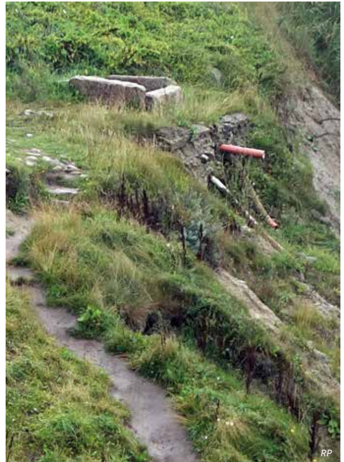
Foto fra 2020, hvor man ser rester af husets fundament
