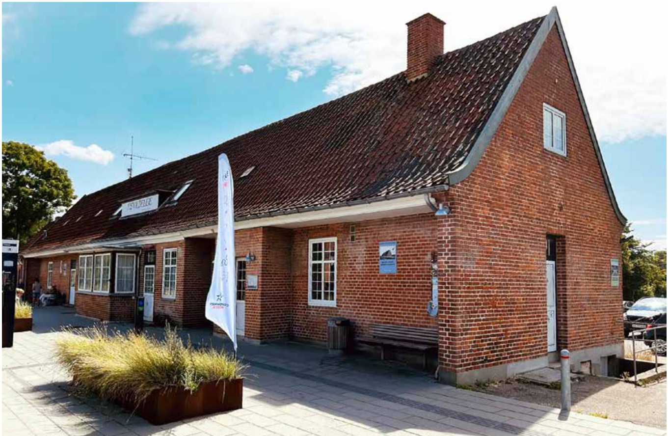
Tisvildeleje Station er et godt eksempel på en bevaringsværdig bygning, som vi skal passe på, selvom den desværre løbende har sine udfordringer med hærværk og graffiti.
