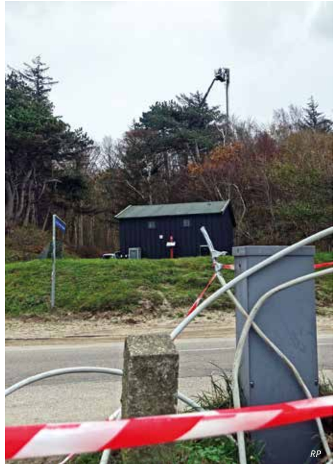
Antenne monteres på masten
